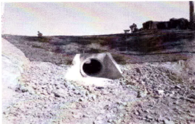
EXECUÇÃO DE ALA DE BUEIRO
